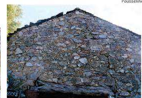
Les joints de hourdage de cette remise se composent de graves terreuses.
