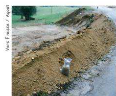
Bord de route en travaux, entre Fraisse sur Agout et Salvergues.
