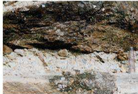
Verrerie de Moussan Mortier des joints de l'église.
