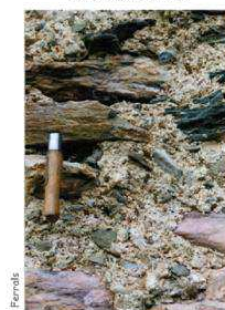
Joint pleins sur une remise de Ferrals. Mortier de chaux et sable grenu.
