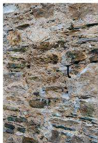
Joint pleins couleur terre. Mortier de chaux, sable grenu et terre.
