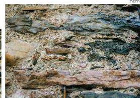
Joint pleins sur une remise de Ferrals. Mortier de chaux et sable grenu.
