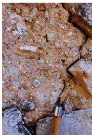
Les joints de hourdage de cette remise se composent de graves terreuses.
