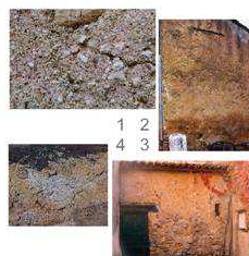
Des mortiers de même composition et de même couleur se retrouvent indifféremment en rejointolement et en d'enduit.
