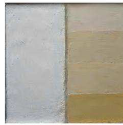
4a - FINITION CL + GRENU + CHAULAGE (CL90 = Norme de la Chaux aérienne) 4b - FINITION CL talochée + BADIGEONS COLORES JAUNES
